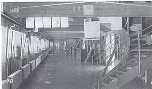
tipiano sono visibili i condotti termoisolati, che trasportano acqua calda per i radiatori disposti lungo la parete e sono fissati con viti alla struttura in legno lamellare. Anche i cavi elettrici sono lasciati a vista, all'interno di guaine elettroisolanti e resistenti al
